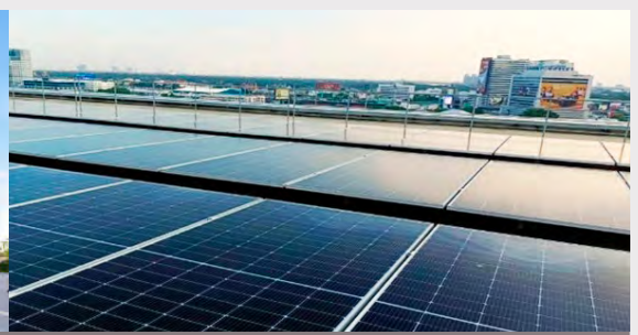
การติดตั้ง Solar Roof ที่โครงการ FYI Center ด้วยกำลังการผลิต 300KW
